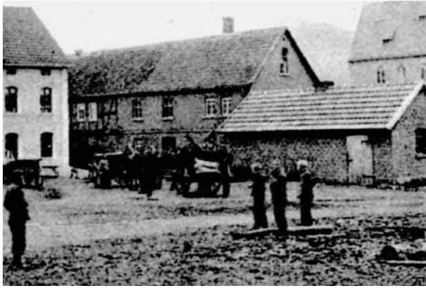
Backhaus am unteren Anger Backofen im Dorfgemeinschaftshaus, Foto: Ausschnitt Postkarte Leihgabe Wendelin Priller bis 1968 im Betrieb (Foto: Leihgabe Ruth Burghardt)
