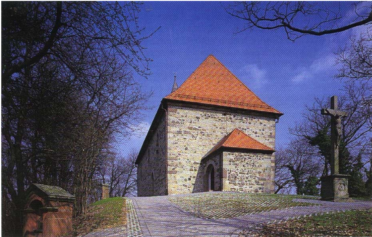
Außenansicht der Wallfahrtskapelle auf dem Gehilfersberg nach dem Wiederaufbau
