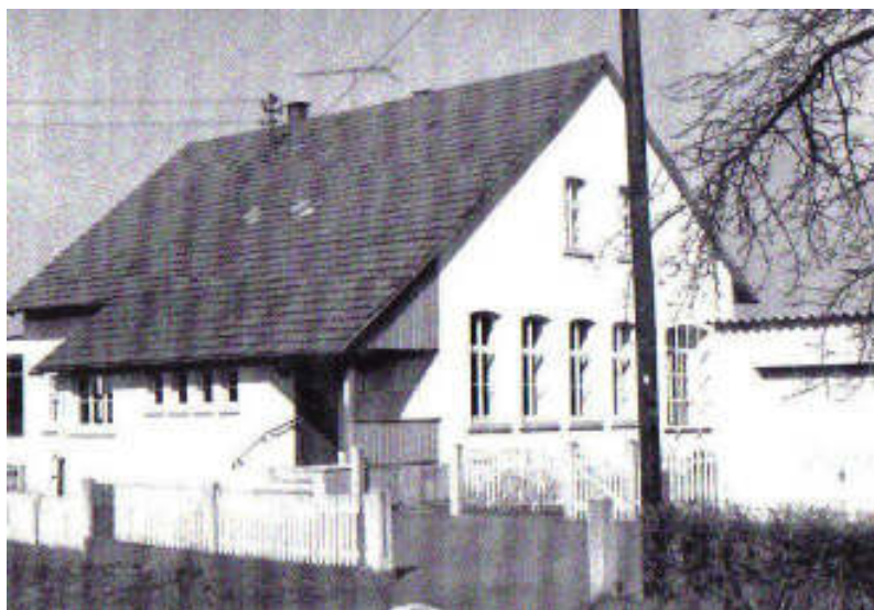
Schule Grüsselbach nach dem Umbau 1953
