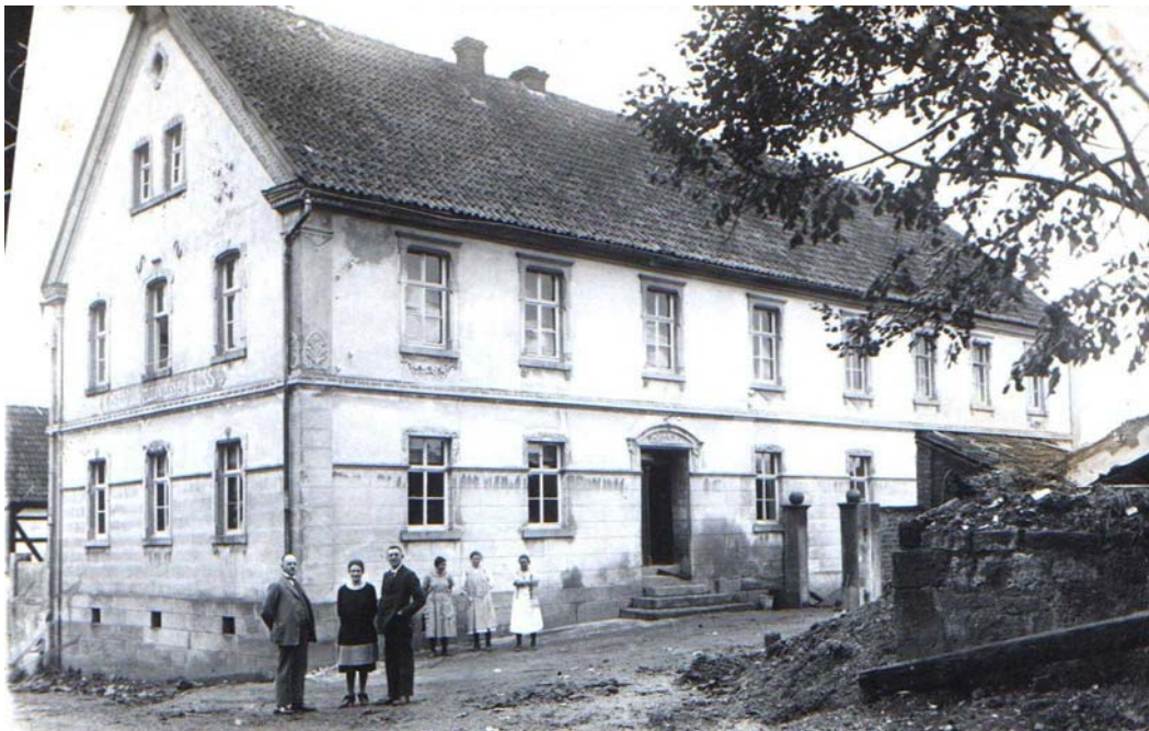
Gasthaus Flach wie es nach dem Großbrand 1875 aufgebaut wurde. Das Foto von 1926 zeigt rechts noch die Trümmer von „Mouruse“ nach dem Ankerbrand.
