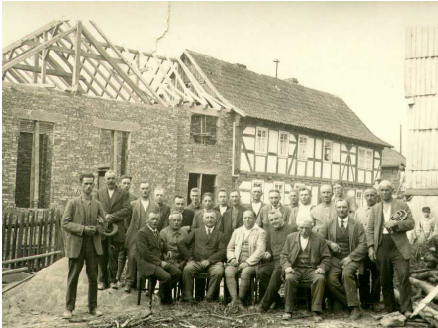
Richtfest des Kindergartensaales
