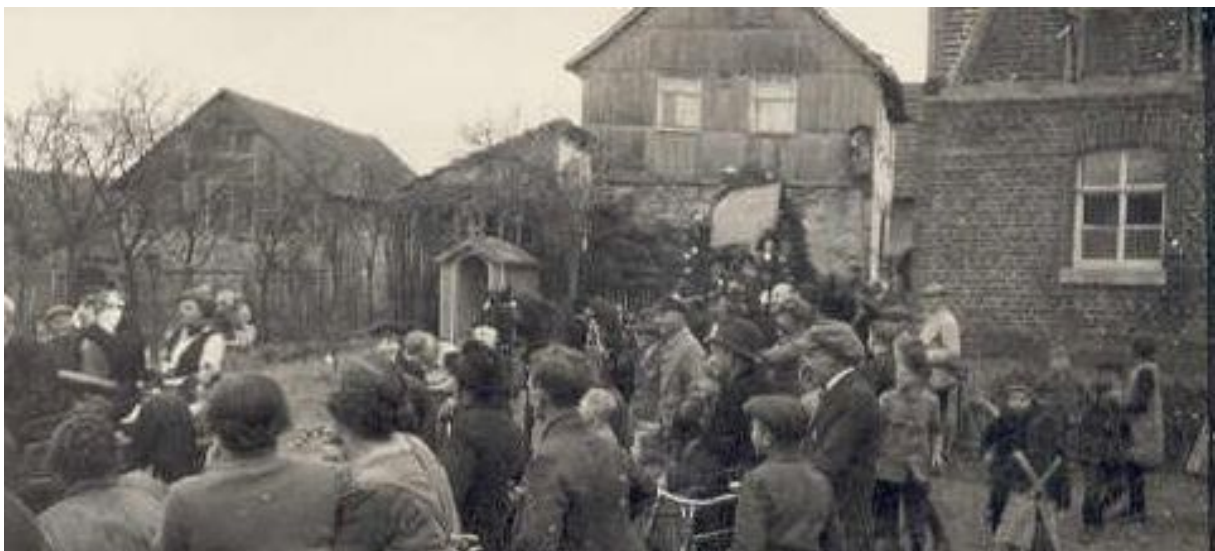
Foto: Fastnachtszug 1926, Bildmitte: Das Torhaus, das in dieser Bauweise schon vor Jahrhunderten so entstanden sein könnte. Das fensterlose Untergeschoss lässt die Vermutung zu, dass ein Gefängnis oder auch ein Warenzolllager hier untergebracht war vor dem Ausbau der Landstraße 1770. Rechts: „Jerres“, links: die Wirtschaftsgebäude des Nachbarn Franz Hahn und die kleine Mariengrotte, die von Hilarius Herget für seine und seiner Söhne glückliche Heimkehr aus dem Ersten Weltkrieg hier aufgestellt wurde.
