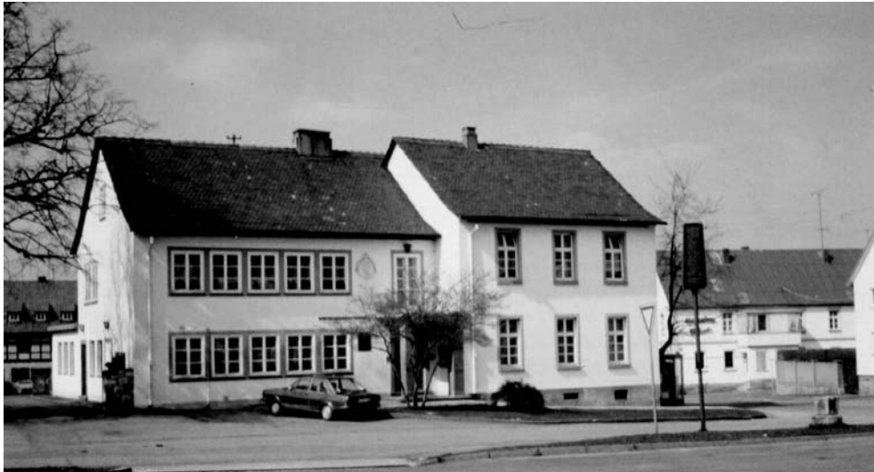
Dorfgemeinschaftshaus nach Fertigstellung
