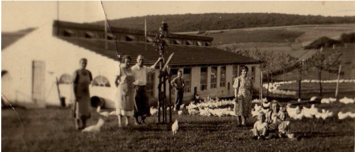
Neuerbautes Stallgebäude nach dem Brand
